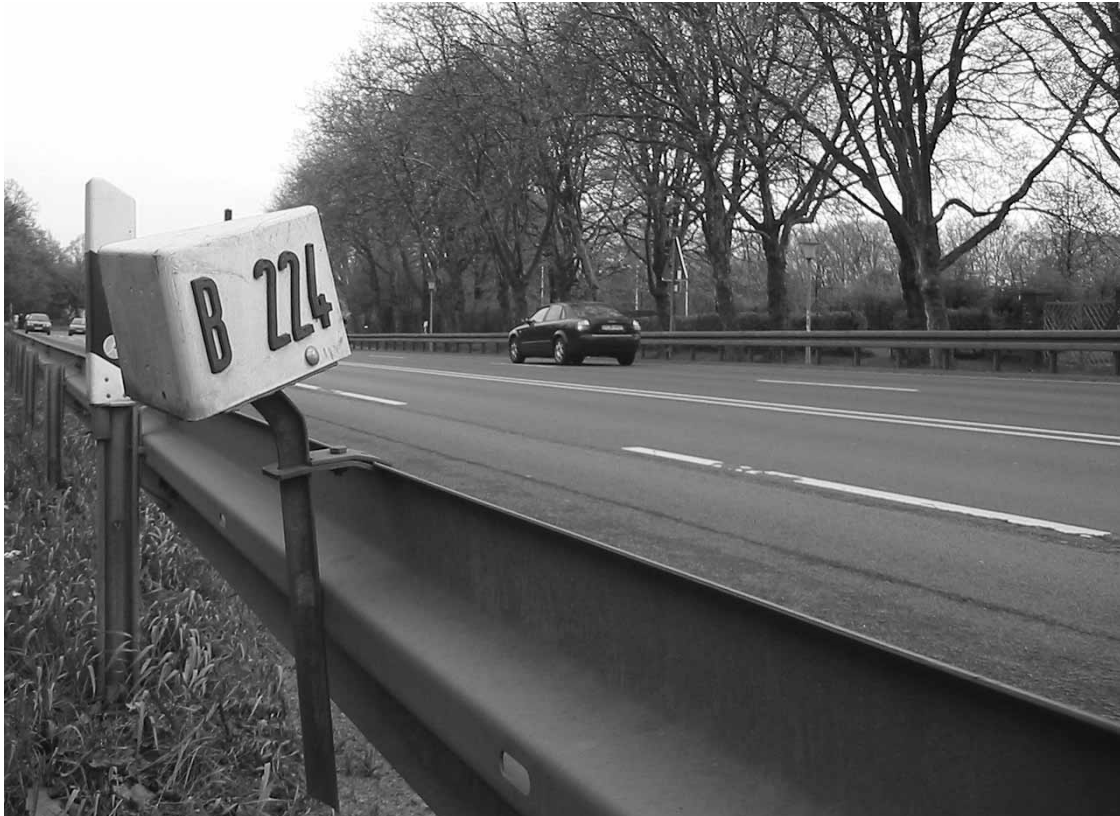
Über die Qualität des Ausbaus der B224 (hier im Bereich des Stadions) zur A52 wird viel diskutiert.
