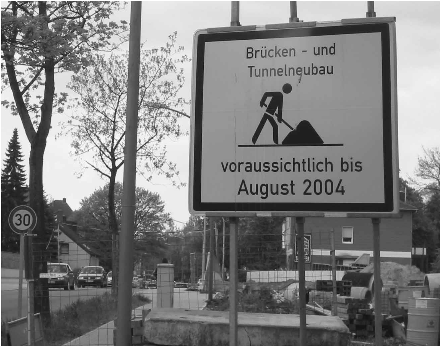
Die Trennwirkung der Autobahn muss mind. im Innenstadtbereich wie hier in Gelsenkirchen-Erle durch einen Tunnel aufgehoben werden.
