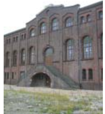
In der Maschinenhalle haben die antiken Möbel zuletzt ein neues Domizil gefunden.
